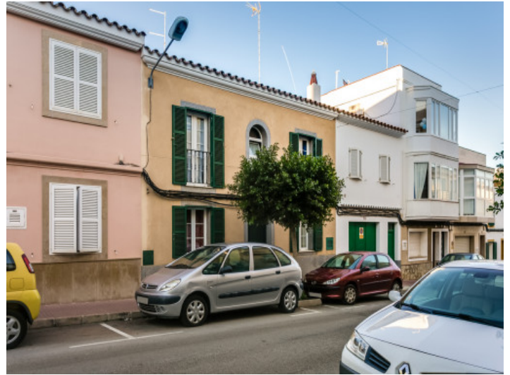
Vista exterior de la casa
