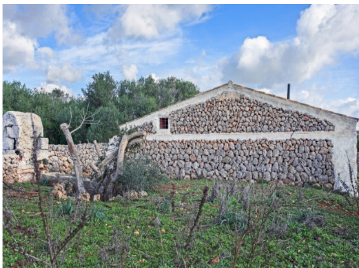
Vista de la fachada
